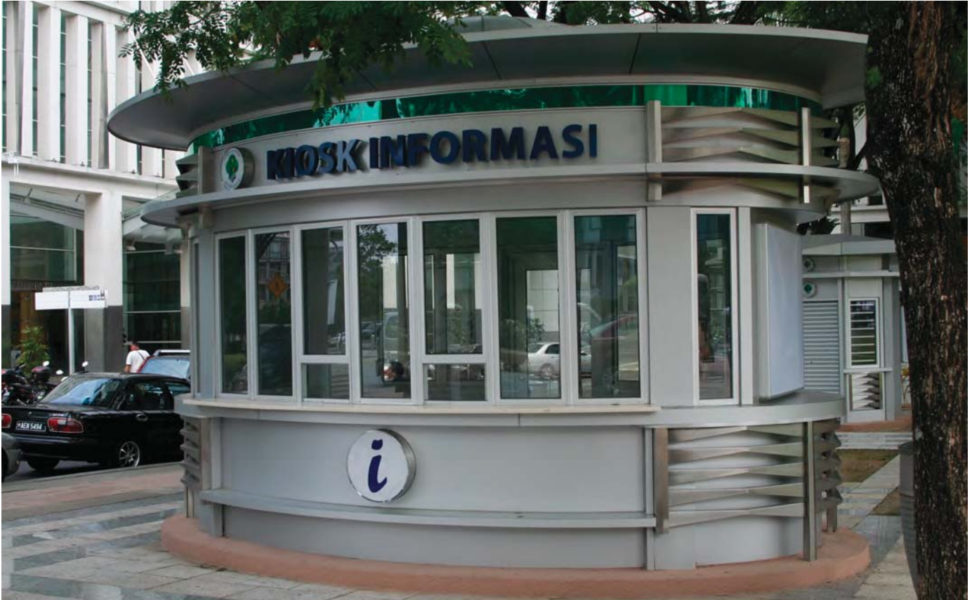
Kiosk-kiosk perniagaan di depan kompleks PPj telah dipasangkan dengan lampu LED dan T6.
