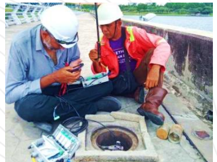
Sistem Keselamatan Empangan Putrajaya (SKEP) menyediakan pengawasan & pemantauan keutuhan struktur secara real-time
