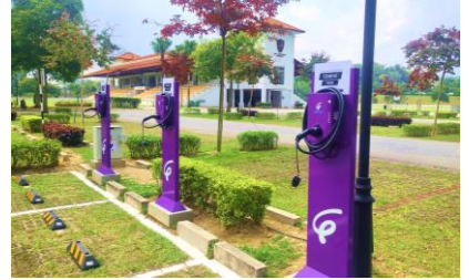
Pemasangan stesen pengecasan kenderaan elektrik
