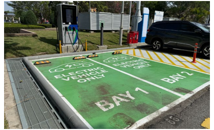
Pemasangan stesen pengecaj kenderaan elektrik
