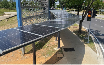
Laluan pejalan kaki berbumbung solar fotovolta (PV) di MRT Putrajaya Sentral, P7 – Pangsapuri Putra Harmoni, P9
