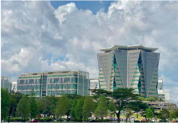
Government Building Block F1 & F2 (GBI-Gold)
