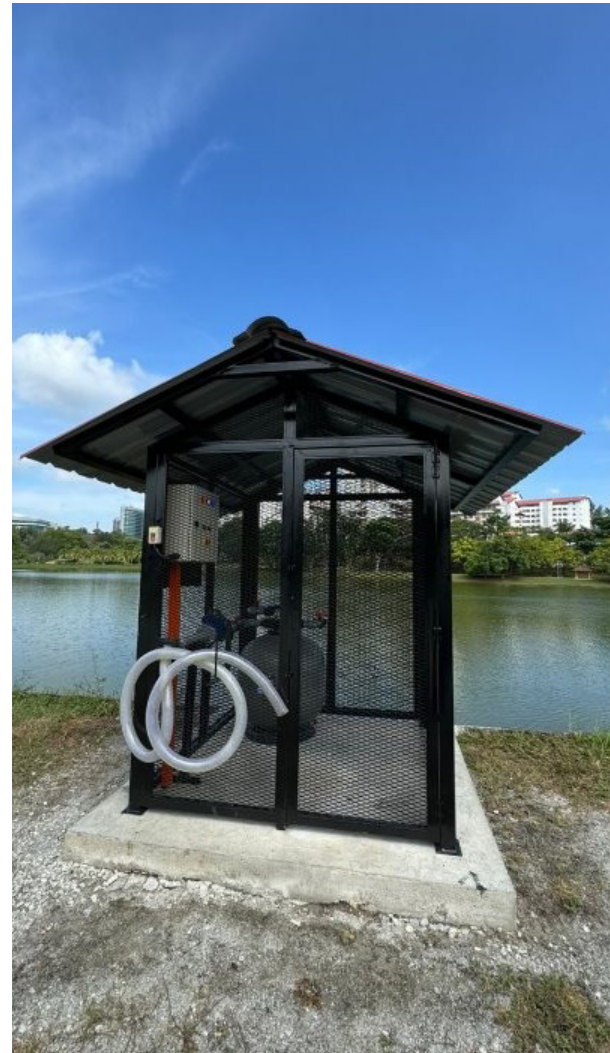
Stesen pengambilan air tasik bermeter di Pusat Penyelenggaraan Bot, Presint 19.
