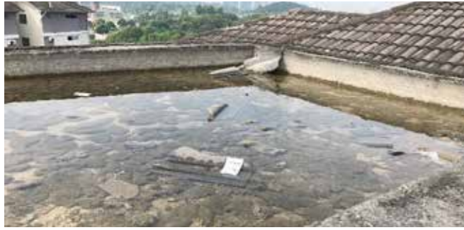
Permukaan Bumbung yang menjadi tempat takungan air dan dikhuatiri kawasan pembiakan nyamuk aedes
