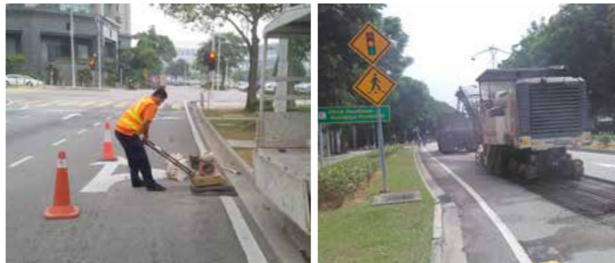
Kerja-kerja penyelenggaraan permukaan jalan raya.
