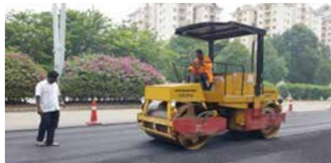
Kerja-kerja pembaikan jalan, garisan dan tanda permukaan jalan serta lain-lain kerja yang berkaitan di jalan-jalan utama sekitar Putrajaya
