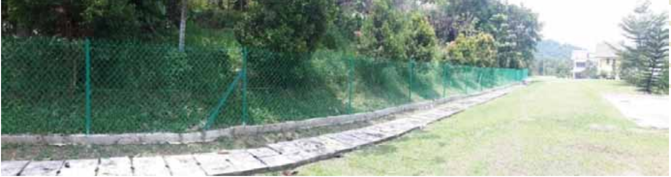
Pemasangan Pagar Keselamatan di Kawasan Perumahan P15A, Presint 15
