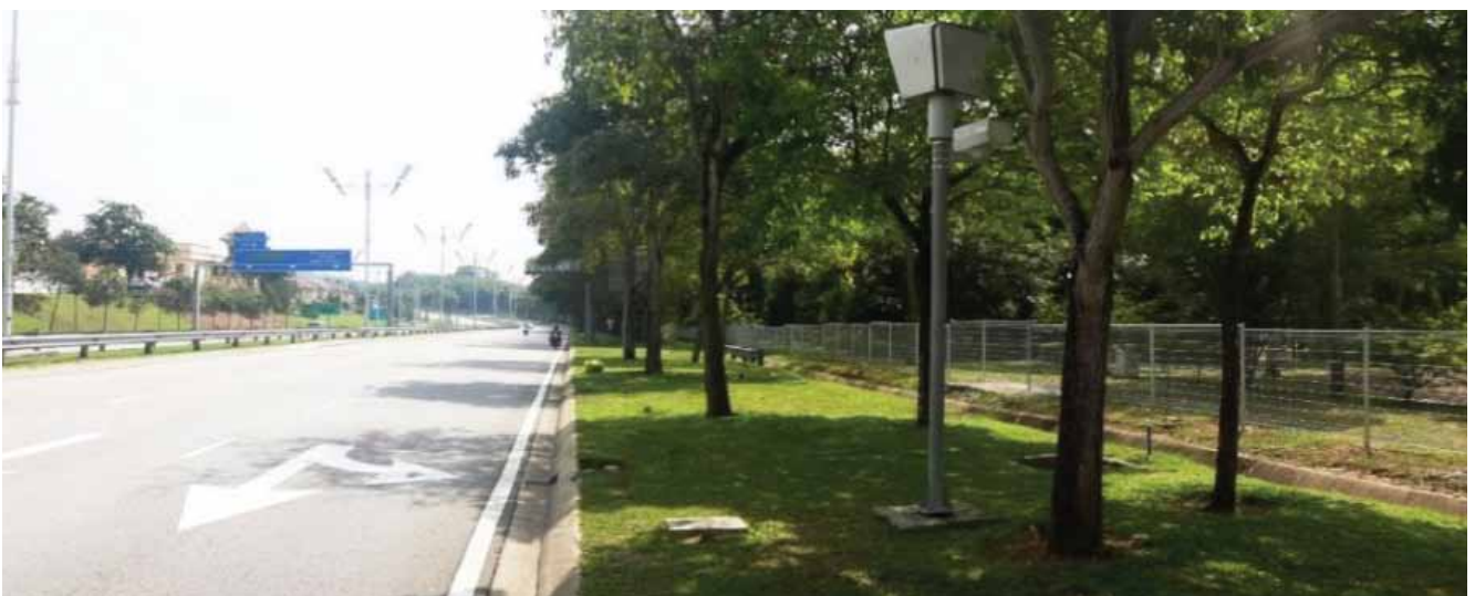
Pemasangan Pagar Keselamatan di Kawasan Perumahan P10A, 10B & 10C, Presint 10
