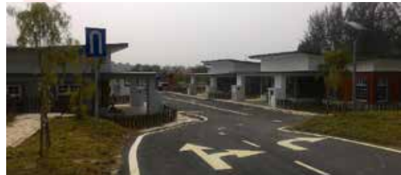
Pembangunan 16 unit Tadika / Taska di Presint 18
